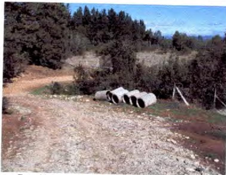
Foto 44: tubos de cemento acopiados, sin instalar
