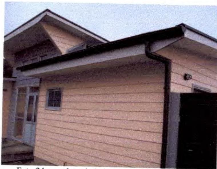
Foto 24: canales y bajadas de aguas lluvia de PVC
