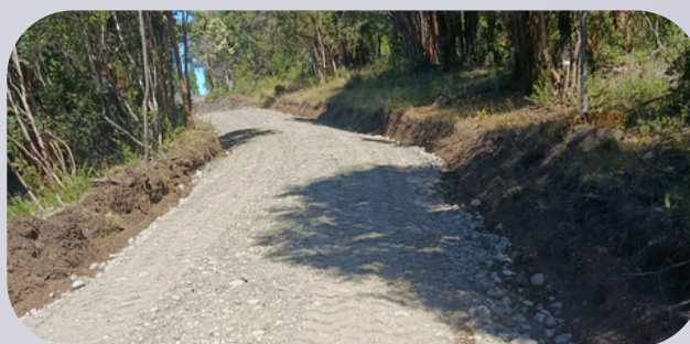
Camino Liucura; 0,155 km de longitud
